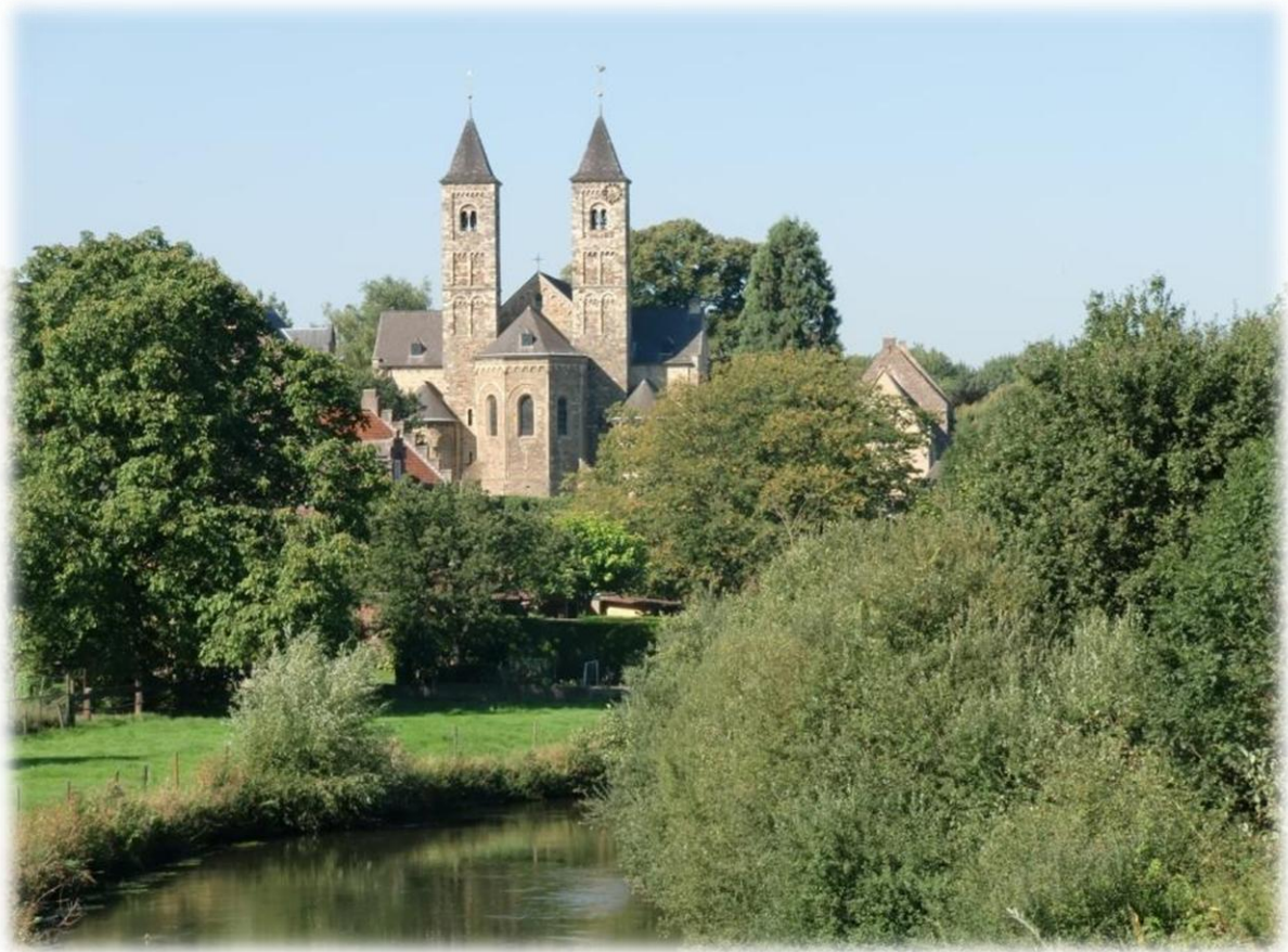
De kerk werd in 1935 naar ontwerp van Joseph Franssen gebouwd. In 1945, een paar dagen voor de bevrijding van Boukoul, werd de toren opgeblazen. De kerk werd in 1946-1947 in de oude toestand hersteld. De kerk heet H. Theresia
